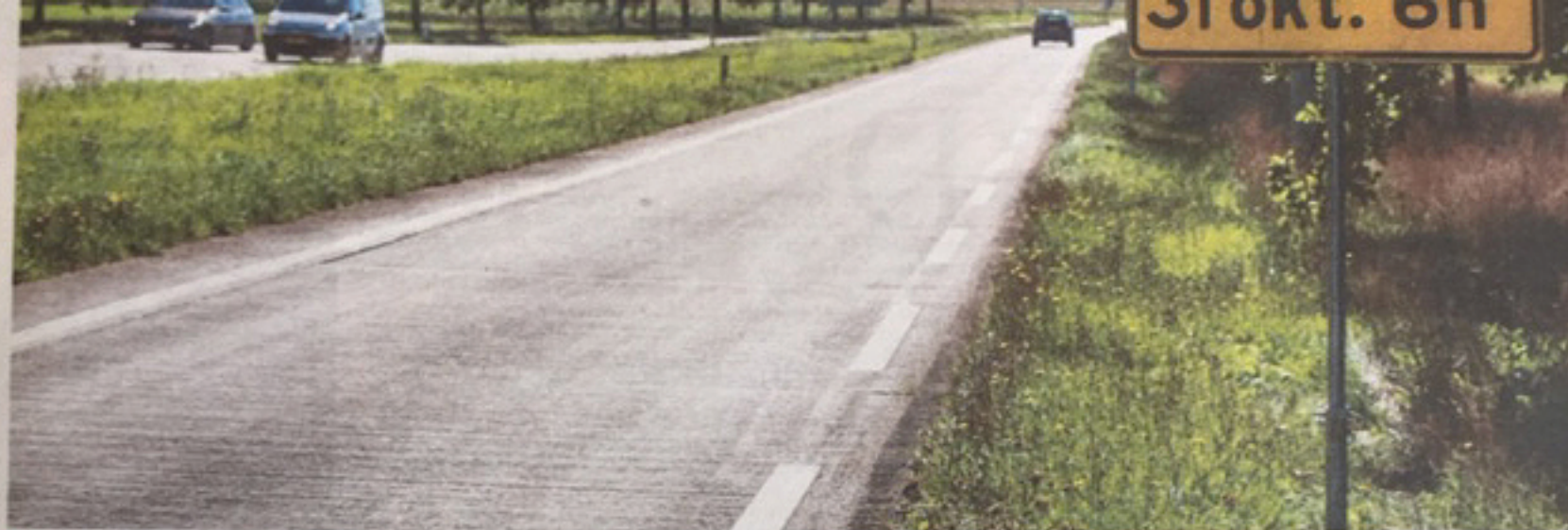
• De N260, de provinciale weg tussen Gilze en Baarle-Nassau, wordt van 12 tot en met 31 oktober compleet afgesloten. De hoofdrijbaan krijgt nieuw asphalt. foto John Schouten/Beeld Werk
